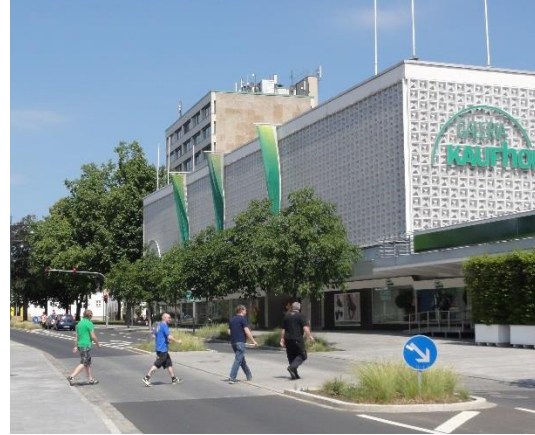
Abbildung 82: großzügige Mittelinsel in Schweinfurt mit Fahrbahnbelagswechsel
