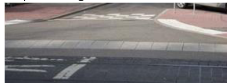
Abbildung 86: "Gehwegnase" mit Aufpflasterung
