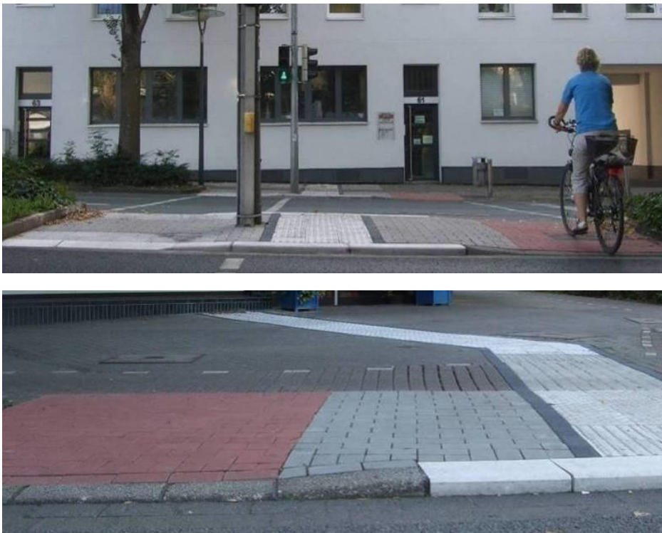
Abbildung 109: Barrierefreie Querungsstelle, die sowohl Seh- als auch Gehbehinderten gerecht wird
