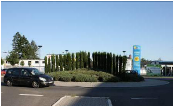
Abbildung 94: gestalterisch ansprechender Kreisverkehr
