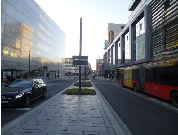
Abbildung 81: Mittelstreifen in Koblenz
