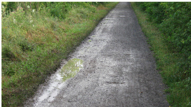
Rad- und Fußweg Paschesiepen - Fahrbahnoberfläche
