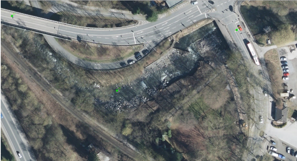
Abb. 35: Die Anlegung der Sohlgleite während der Bauphase 2018
