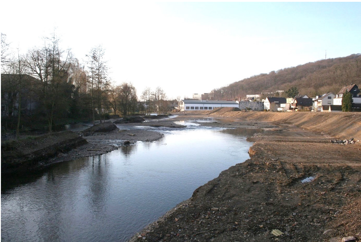
Abb. 31: Höne im Bereich nördl. Horlecke kurz nach Maßnahmenabschluss im Februar 2017
