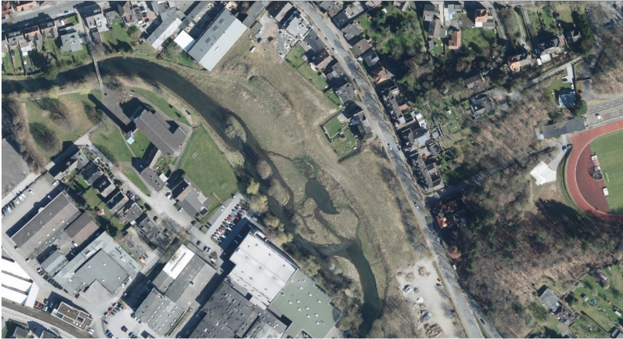
Abb. 30: Nördliche Horlecke nach der Renaturierung - Luftbild 2018
