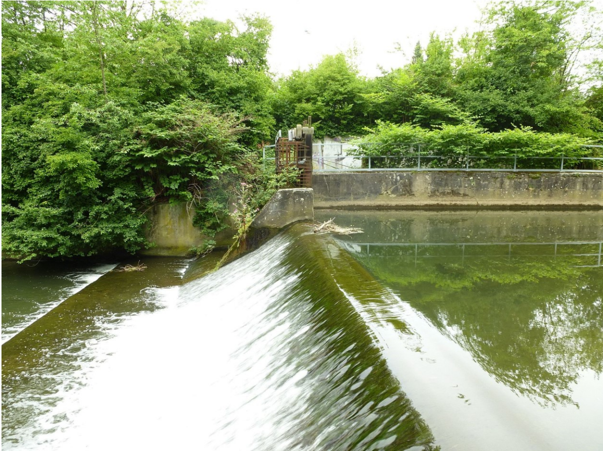
Abb. 34: Die Wehranlage im Juli 2015
