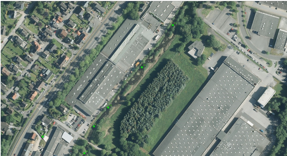
Abb. 27: Oese im Bereich Hassenbruch nach der Renaturierung - Luftbild 2015
