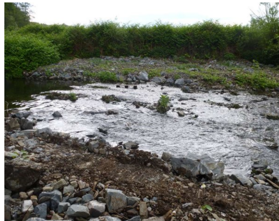
Abb. 19: nach Wehrrückbau Mai 2018
