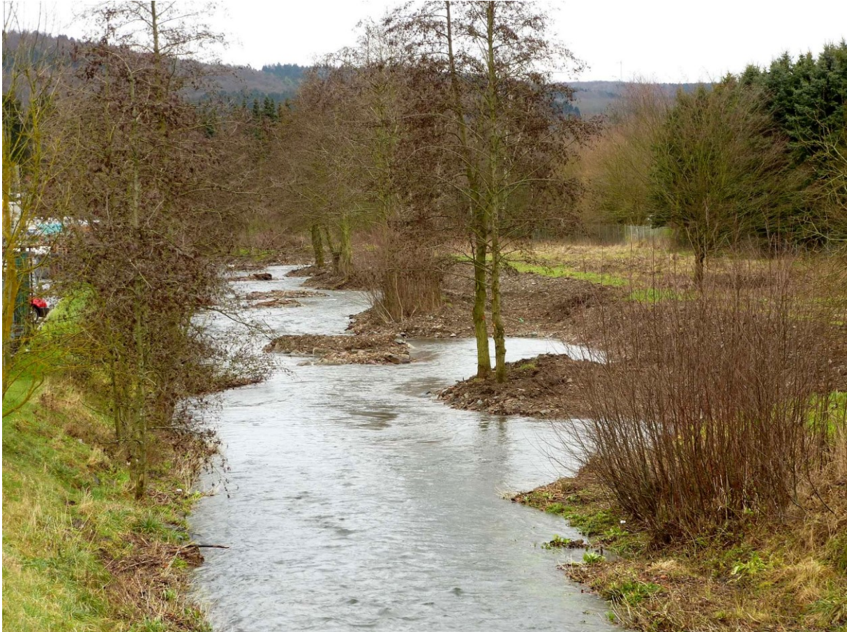
Abb. 28: Oese im Hassenbruch - Maßnahmenumsetzung Ende 2014
