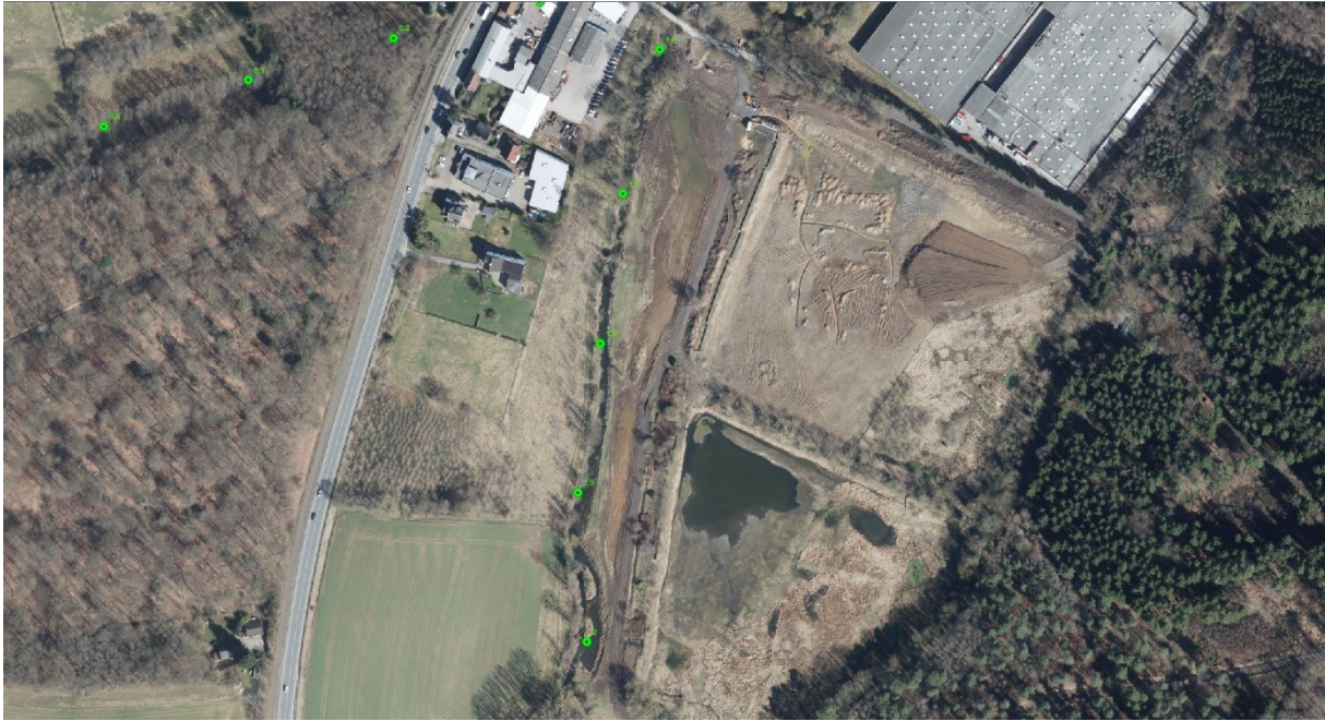
Abb. 17: Oeseaue / Oeseteiche während der Renaturierungsmaßnahme - Luftbild 2018
