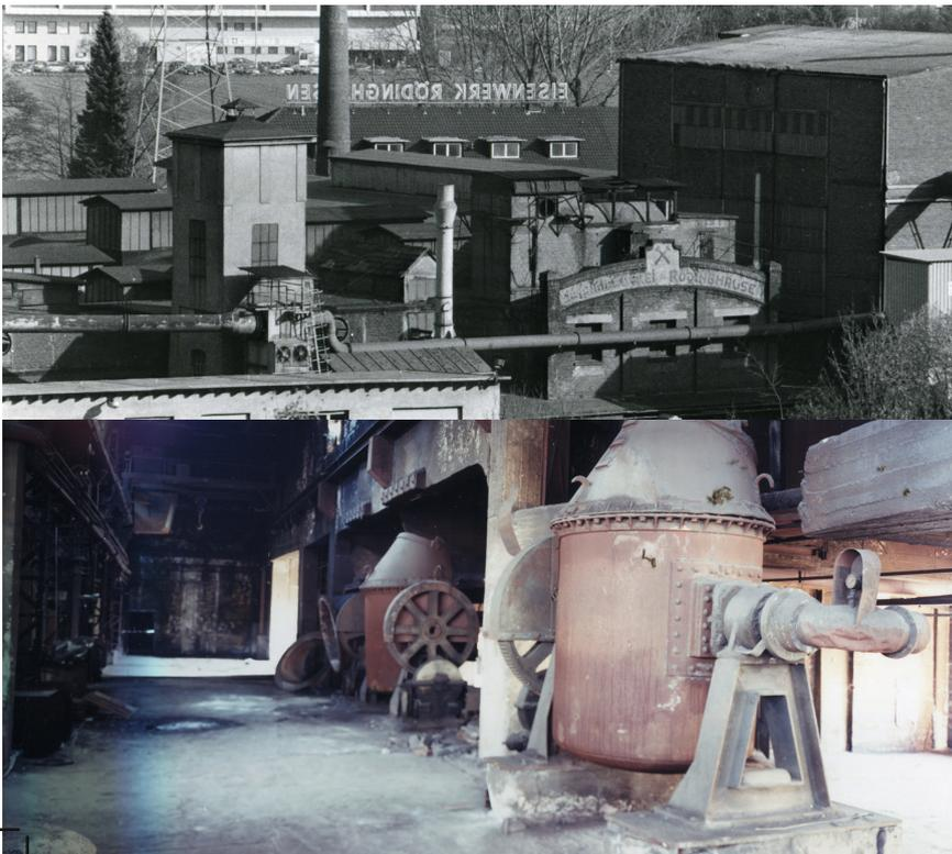
1890 wird die Eisengießerei Rödighausen in Lendringsen gegründet. In zwei Kuppelöfen wird Graugusseisen zur Herstellung von Gussteilen erschmolzen. Nach Errichtung einer neuen Gießhalle 1915 wandeln dort drei Bessemer Birnen Roheisen zu Stahl. In dem 1856 von Henry Bessemer entwickelten Verfahren wurde Luft von unten in eine flüssige Roheisenmasse eingeblasen. Damit ließen sich 9 t Stahl in 20 Minuten herstellen - zuvor benötigte man 24 Stunden.
