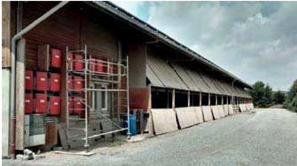
Abbildung 10: Freie Lüftung mit Klappen (Vergleichstall der Inhaberin „Baudissin“)
