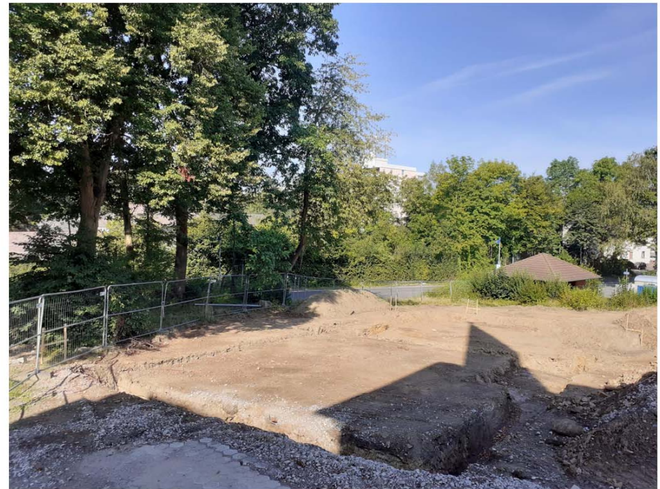
Bestandsfoto, Baugrube Stadtteilhaus
