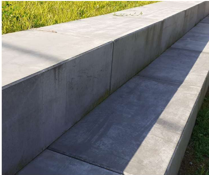
Mauer aus Betonsteinquadern Kita Aussenanlagen
