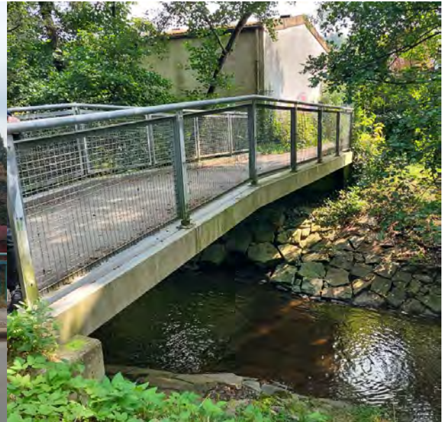
Abb.4: Brücke II am Bieberwinkel
