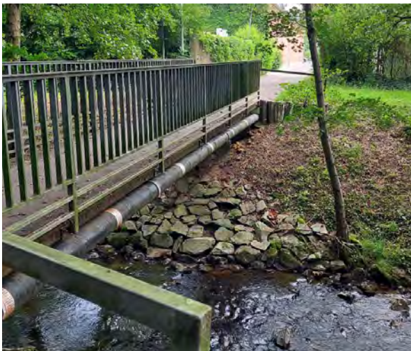
Abb. 5: Brücke III, Bieberkamp
