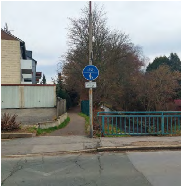
Abb. 3: Brücke I, Einstieg Meierfrankenfeldstraße
