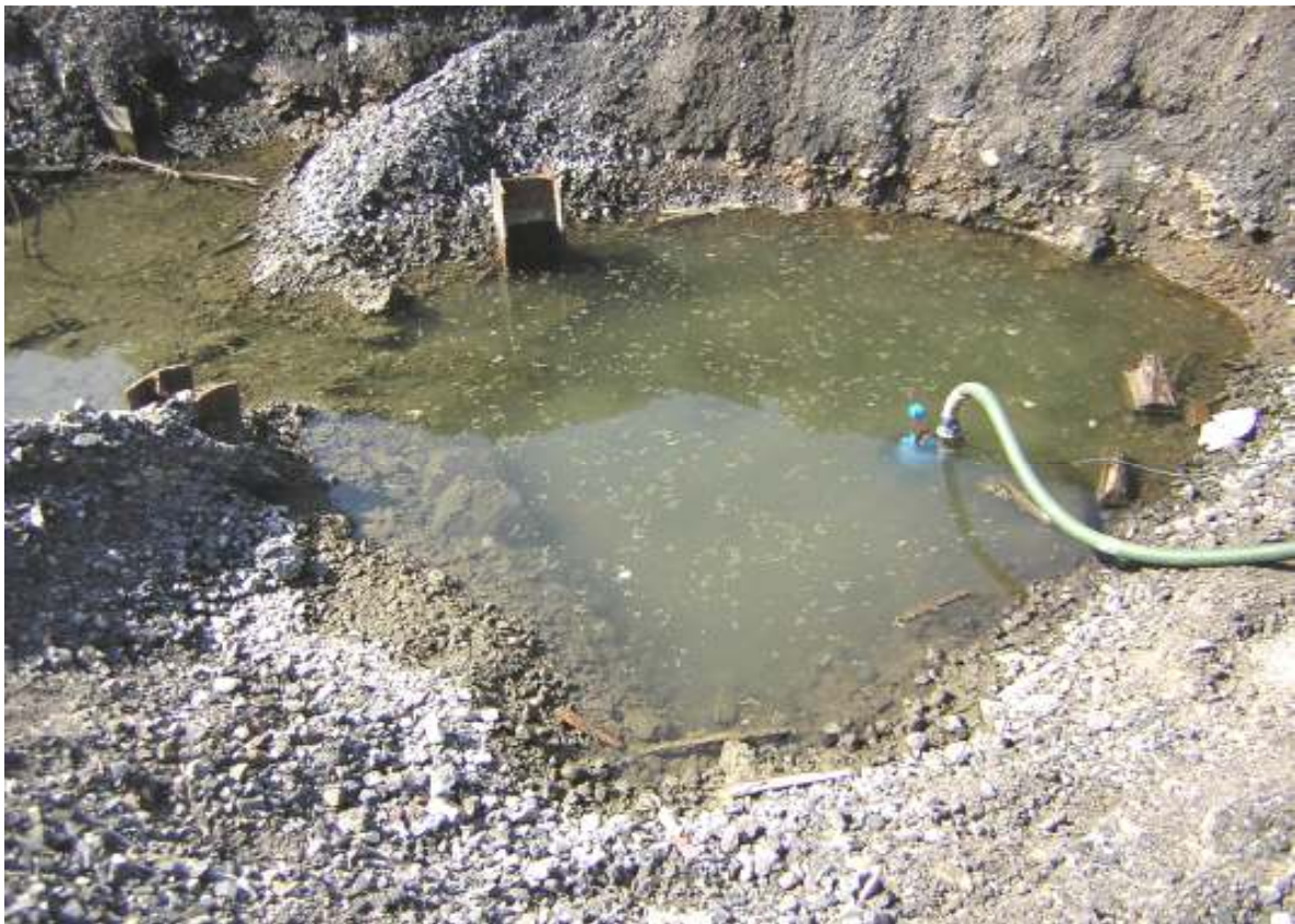
Abbildung 6: Grundwasserblänke im Bereich der kontaminierten Aufschüttung
